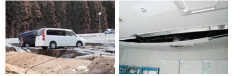
白河事業場の駐車場の液状化 白河事業場の天井板落下
