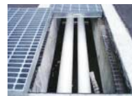
廃水管地上化
