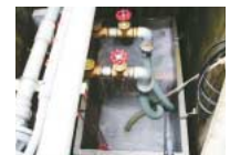
中継槽の二重構造化
