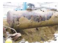
地下タンク撤去
